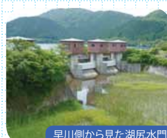
早川側から見た湖尻水門
