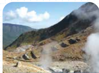
大涌沢の地すべり防災対策箇所
