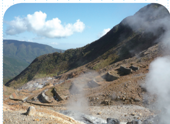
大涌沢の地すべり防災対策箇所
